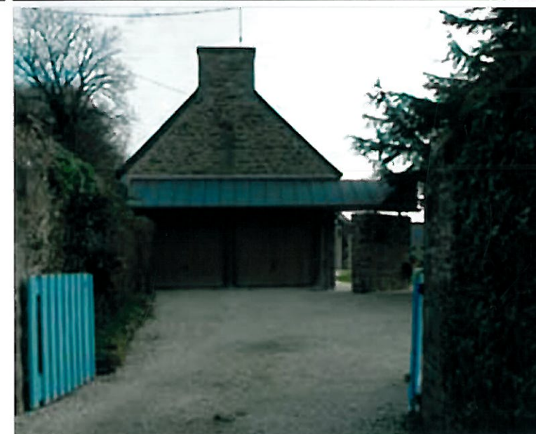
Photos après travaux (février 2007)
