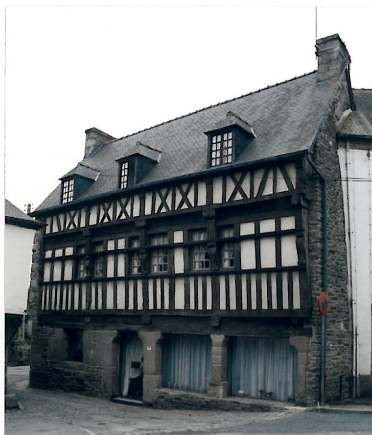
N°7 - Bâtiment Ins. I.S.M.H
