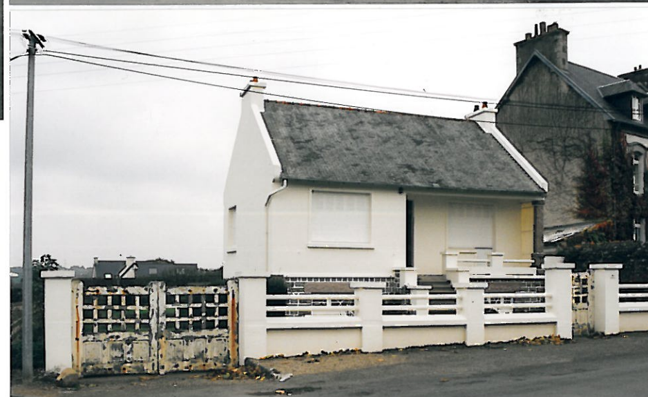
N°7 - Bâtiment discordant
