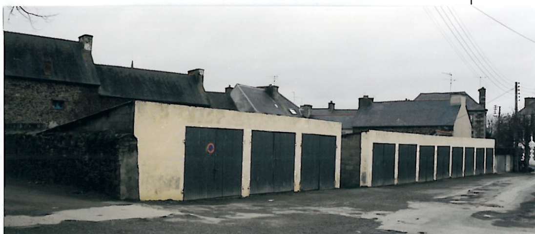
N°2 - Bâtiment discordant - parcelles n° 150 à 170 incluses
