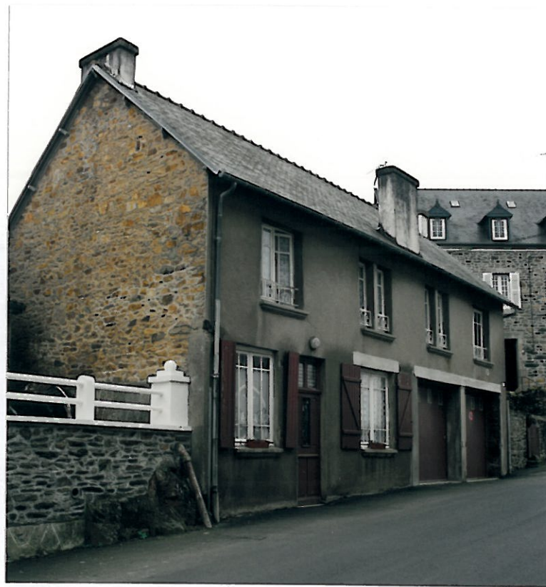
N°7 - Bâtiment sans intérêt architectural
