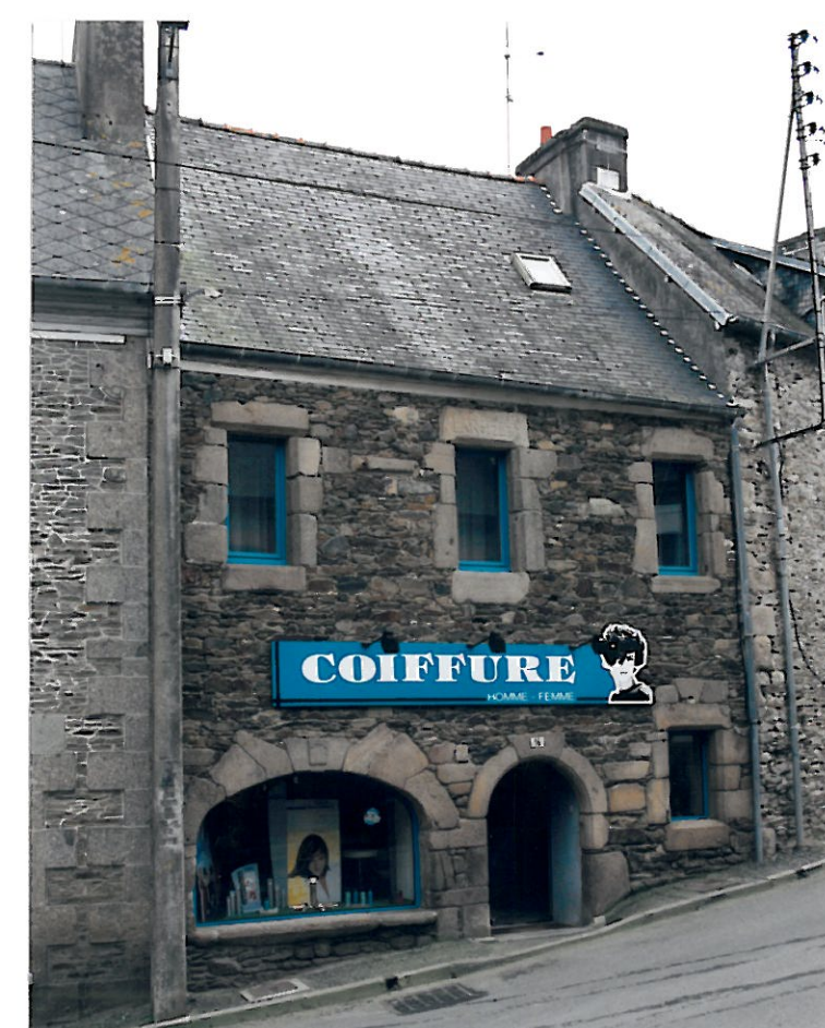
N°16 - Immeuble d'intérêt architectural à grande valeur patrimoniale
