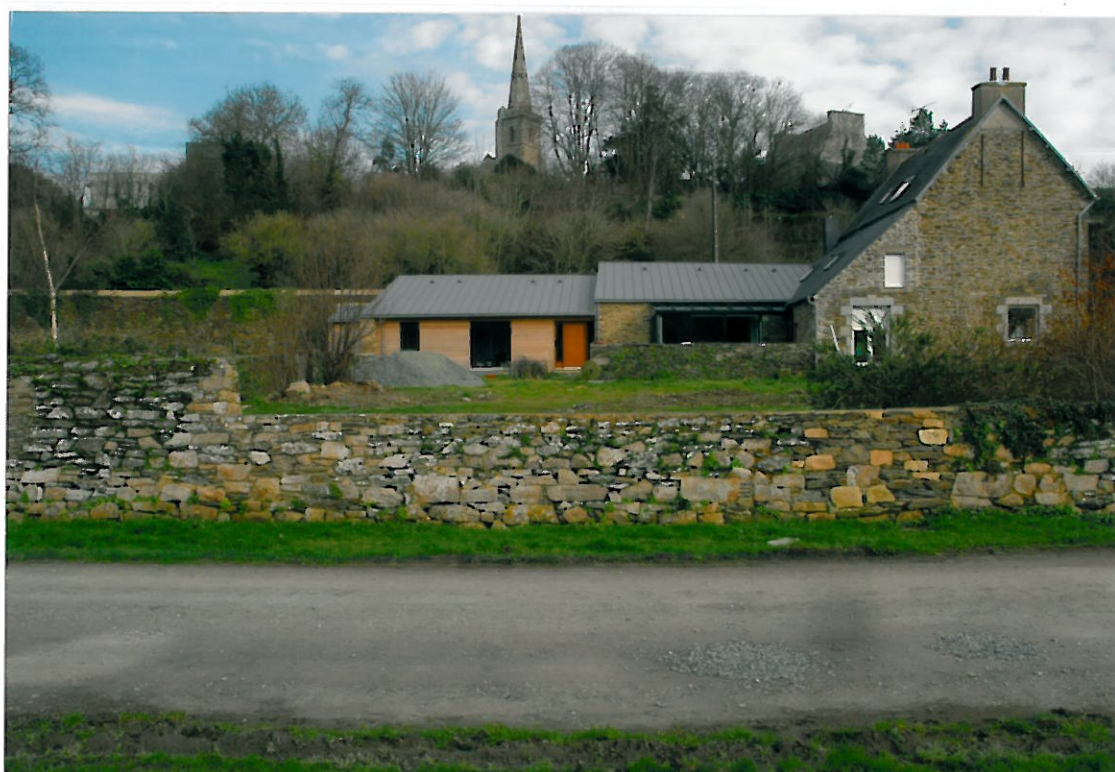
Photo après travaux (février 2007)
