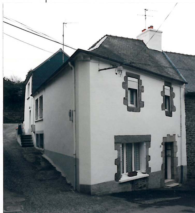
N°2 - Rue du Piloni
