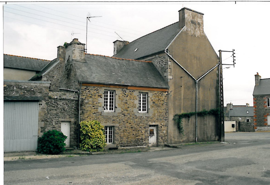
Façade n°1 située place du Pouliet
