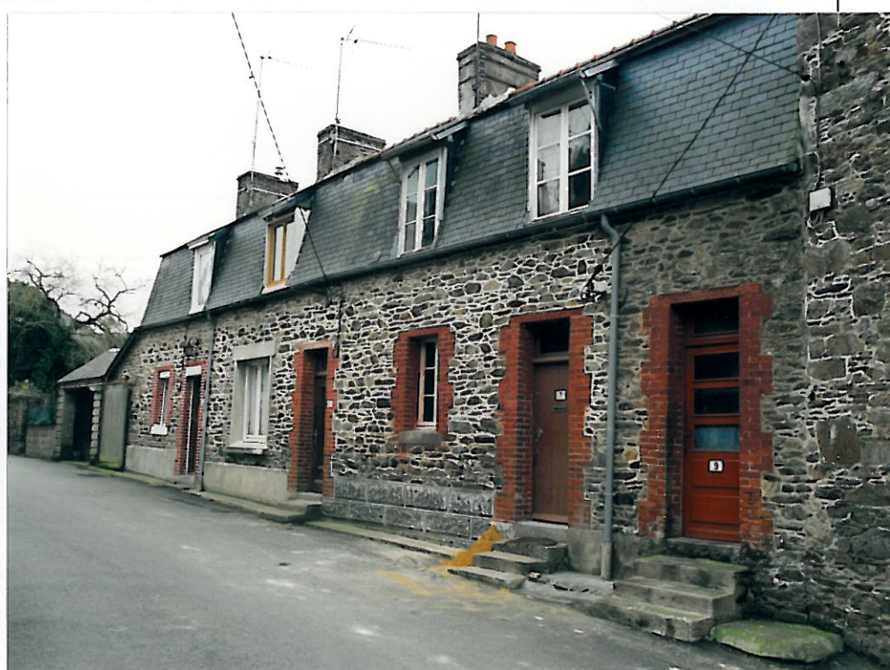
N°3 - 5 - 7 - 9 – Photo avant travaux
