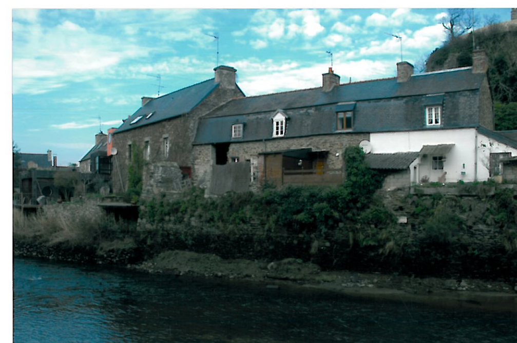
Photo après travaux
