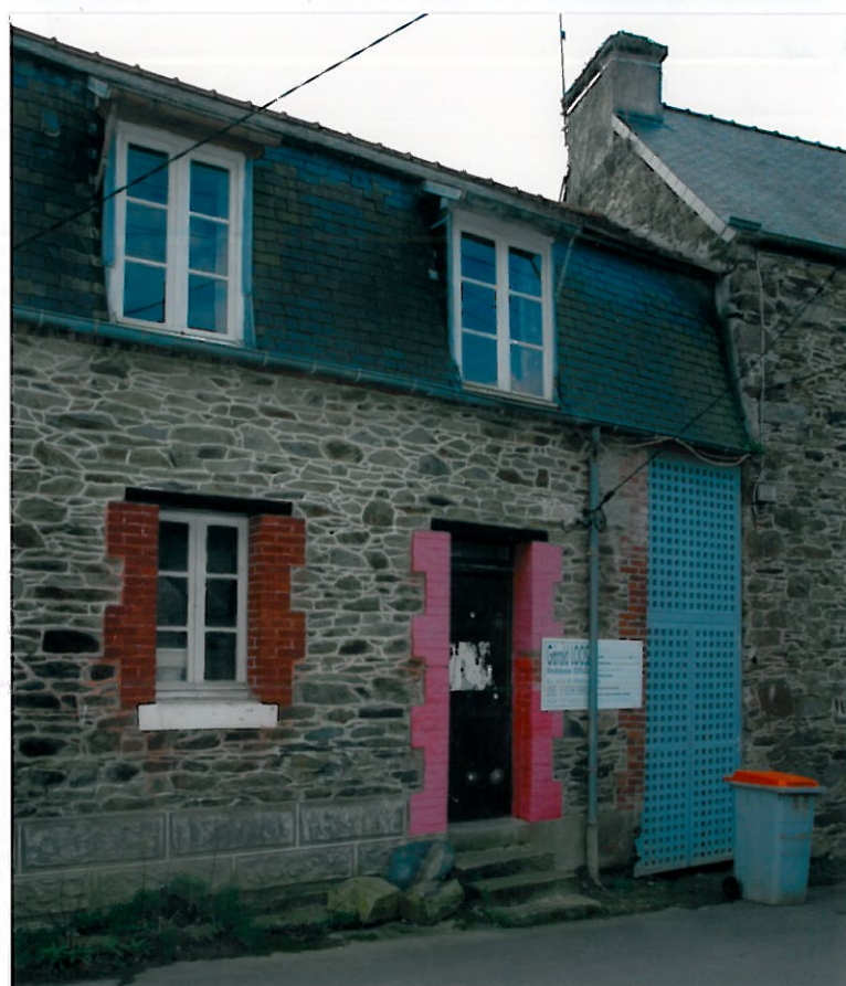
Photo après travaux
