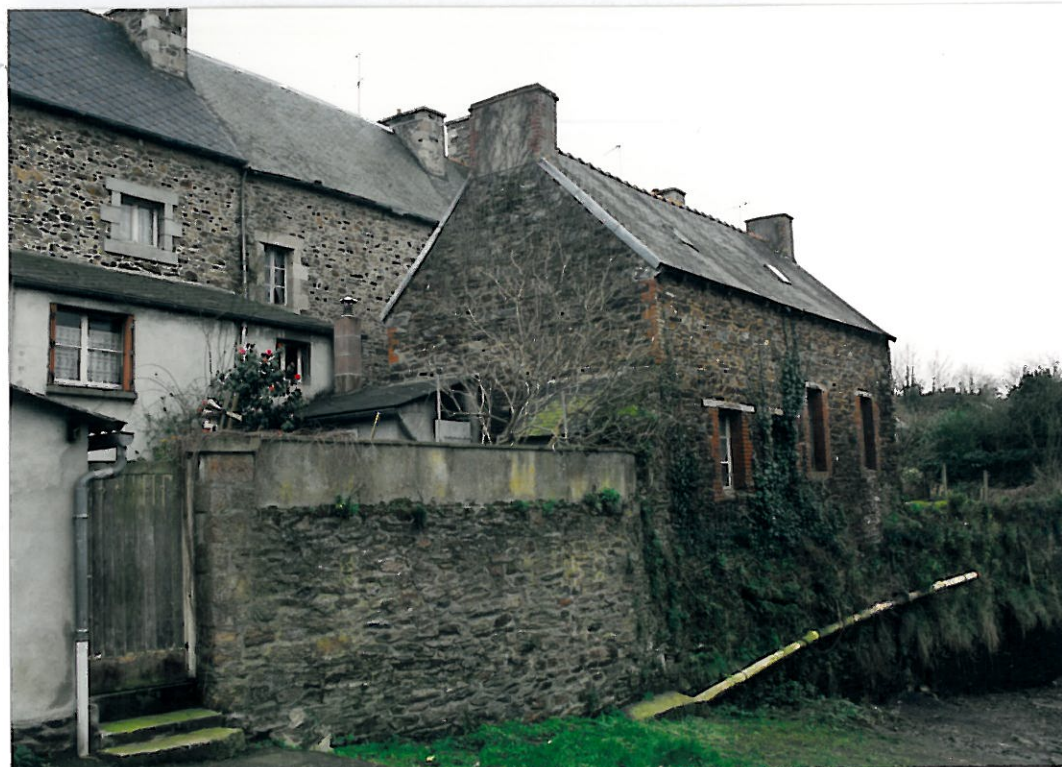
N° 4b - Bâtiment d'accompagnement
