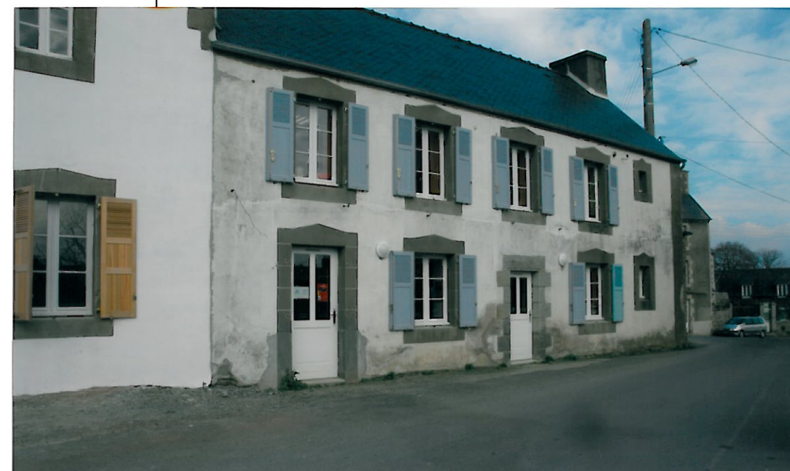
Parcelle n°39 - Façade Sud
