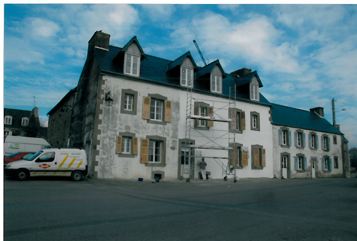
Parcelle n°39 - Façade Sud
