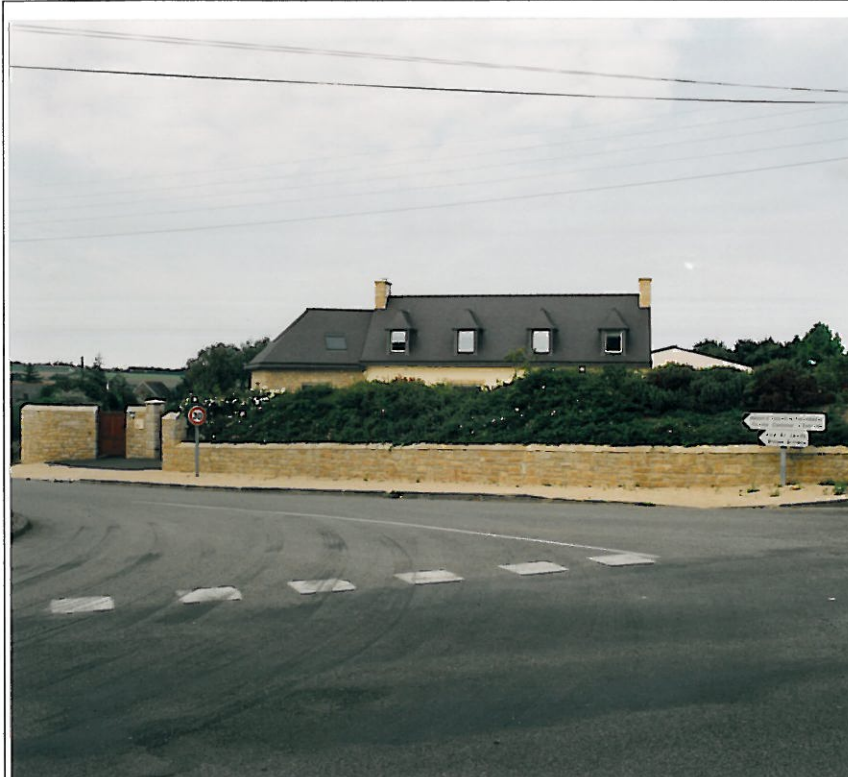
Parcelle n°214 - Bâtiment sans intérêt patrimonial
