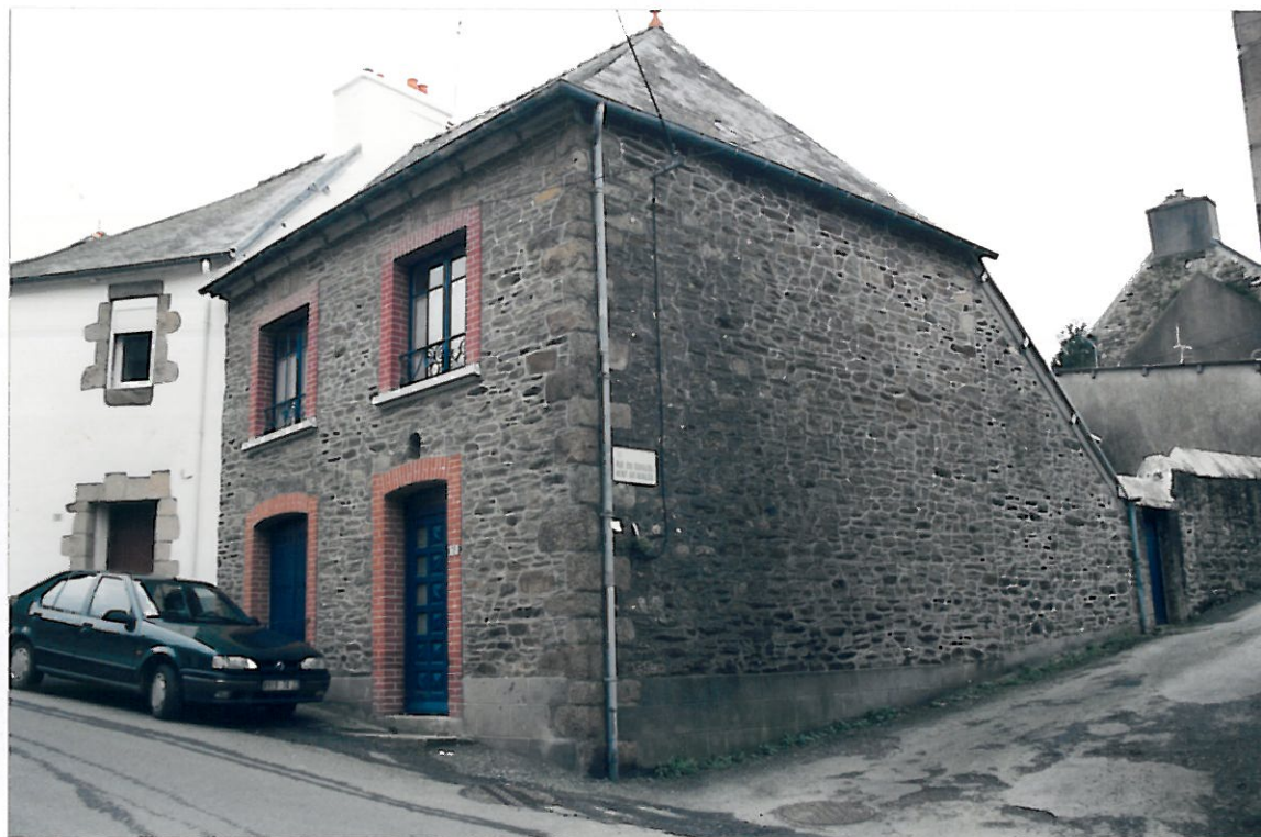
Parcelle n°196 (façade principale n°15 rue de la Fontaine)
