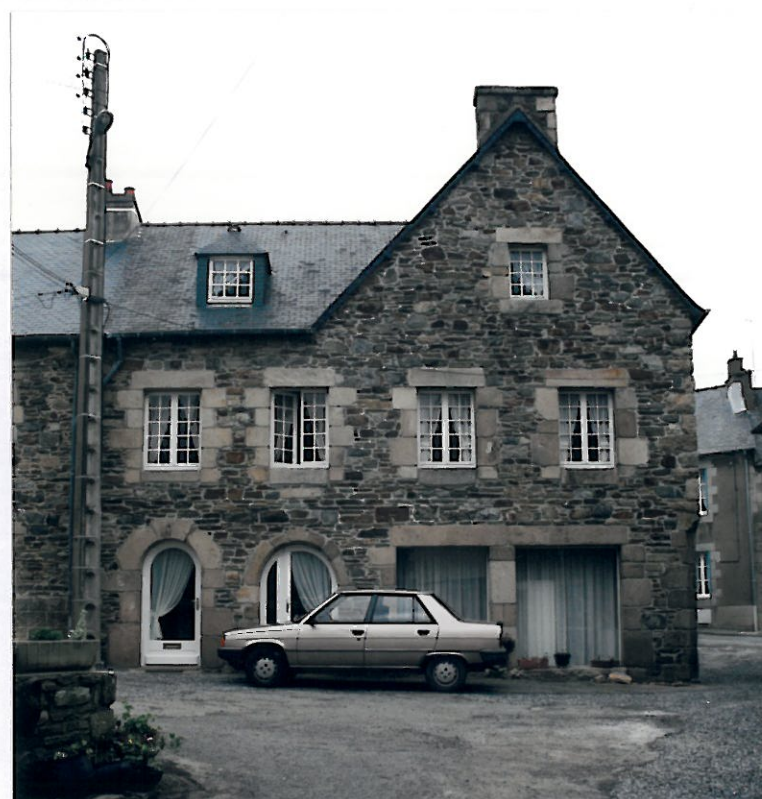
N°2 - Bâtiment Ins. I.S.M.H (partie Est) Bâtiment d'accompagnement (partie Ouest)
