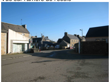
Ancien garage (centre bourg)
