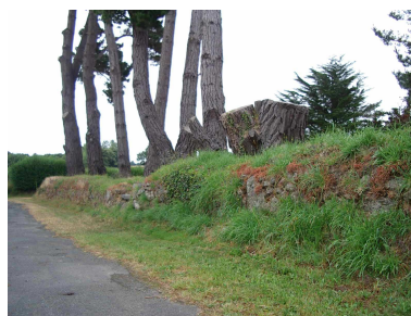
Mur talus à Crec'h An Bris
