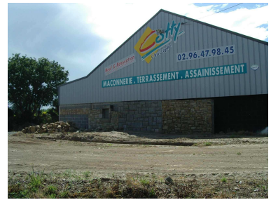
Bâtiment artisanal de Rugoasvin/kerzalaen
