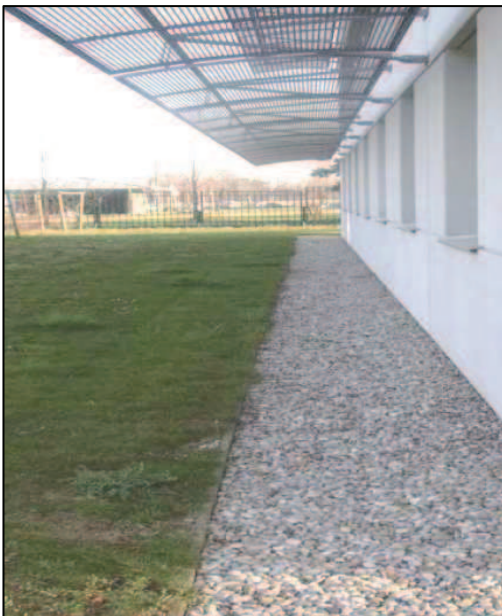
▶ Tranchées sous toit
