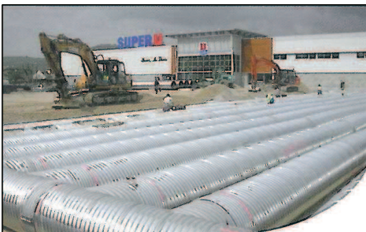
▶ Rétention EP visitable sous voirie SPIREL®- TURBISIDER
