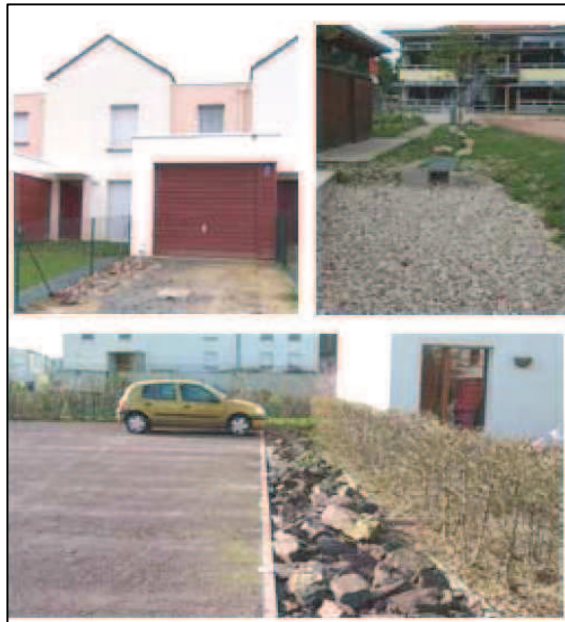
Tranchées drainantes récolant les eaux de parking (Saint Jacques de la lande, 35)
