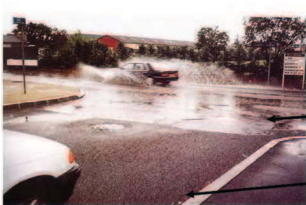
Chaussée à structure réservoir, Craponne (CERTU - 1994)
