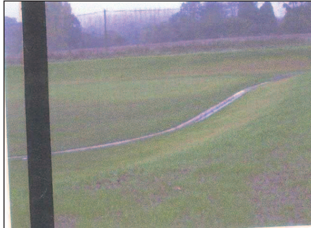
Photo 13 : Bassin paysager avec cunette centrale en béton dont le tracé rappelle celui d'un cours d'eau
