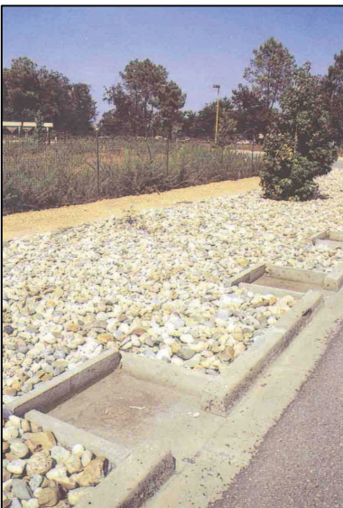
▶ Tranchées le long de la voirie
