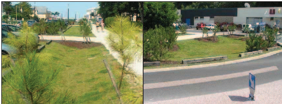
Photo 14 : Exemple de réalisation de noues paysagères
