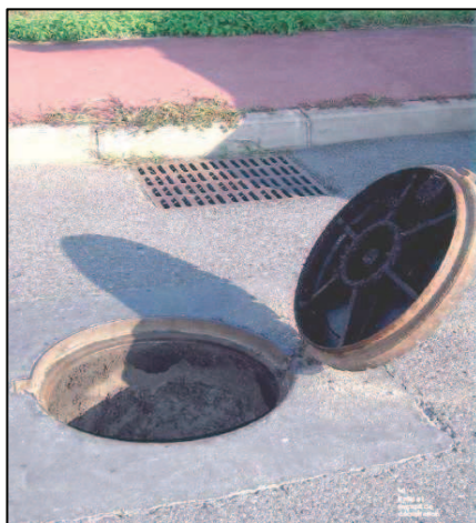
▶ Puits d'infiltration sur voirie (à éviter)
