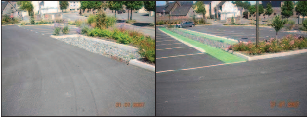
Photo 15 : Exemple de tranchées drainantes
