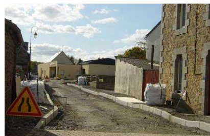
Rue de la gare en travaux
