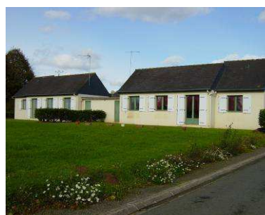
Lotissement de Kerdrez
