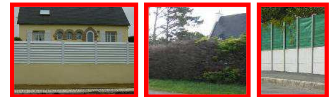
Exemples de dispositifs à éviter
