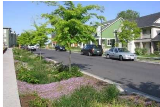
Petite noue plantée selon le principe de jardin filtrant ou « bioswale »
