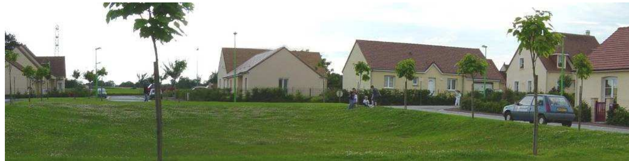
Bassin de rétention faible profondeur
