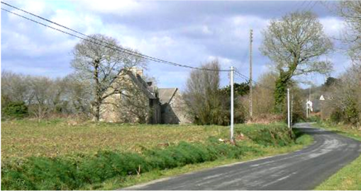
↑ Miroirs du sous-sol, ces figures bâties jouent la carte du mimétisme dans la trame bocagère (Saint-Jean)
