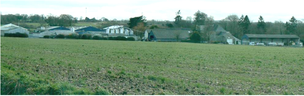
↑ La nouvelle « monumentalité agricole » mise à nue (G.A.E.C de la Haye)
