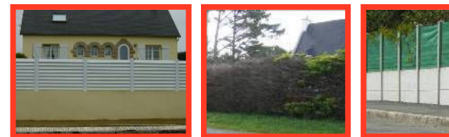
Exemples de dispositifs à éviter
