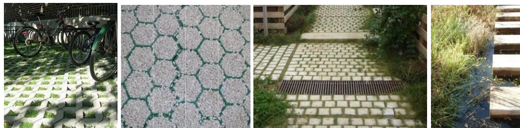
Exemple de matériaux perméables : dalle béton enherbée, gravillons, pavés non jointoyés, pas japonais
