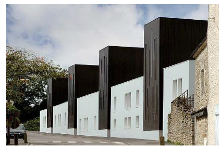
Habitat collectif Saint Nolf, ARCAU architecte
