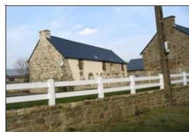
Patrimoine épars : un bel exemple de réhabilitation au Lorrain
