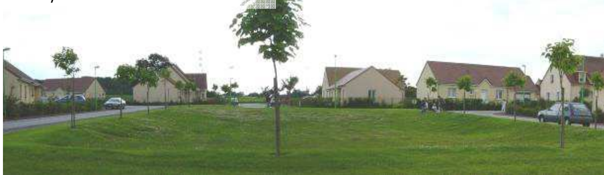
Exemple de bassin de rétention
