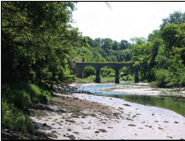
Début de l'estuaire secteur aqueduc Moulin l'Evêque
