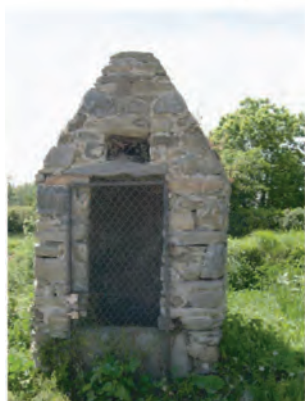
Puits à l'entrée du bourg
