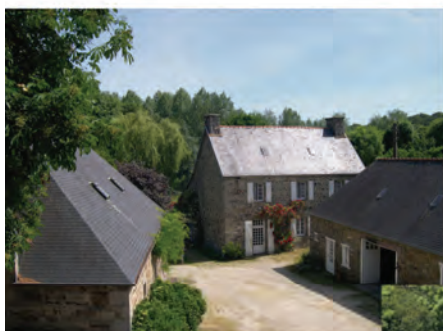
Moulin du Pont Neuf
