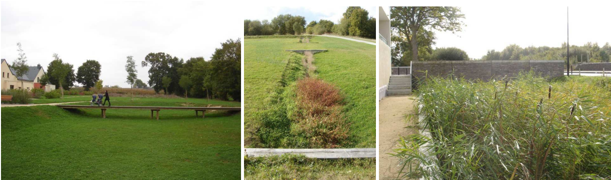
Exemple de bassins paysagés et noues plantées
