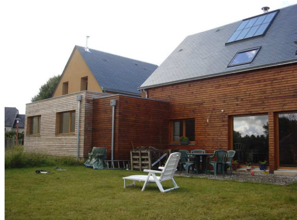
Ou par une dépendance (Langouët, architecte : Menguy)
