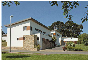
Habitat individuel Vannes, ARCAU architecte
