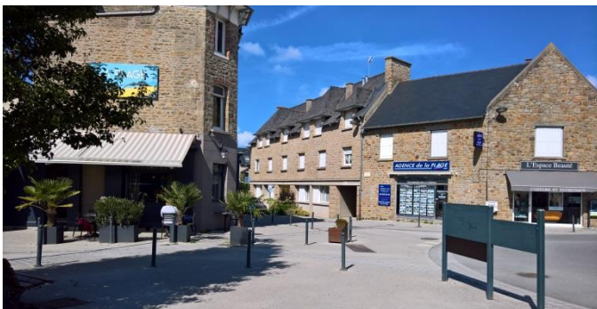
Espace public aménagé, rue de la Plage
