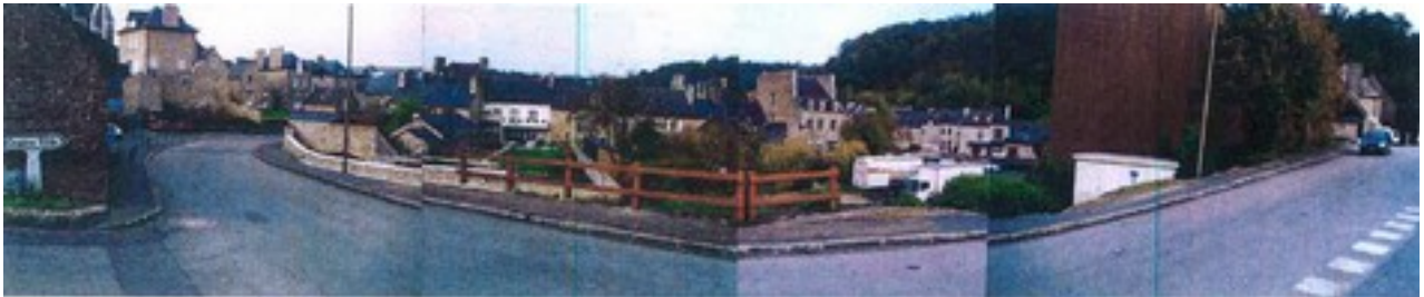
DIGUE DU LAC DE JUGON, ouverture de la vue en surplomb, sur les arrières des constructions de la rue des forges.
