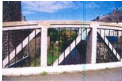
Balustrade du pont lourde, en béton, haute, peu transparente.
