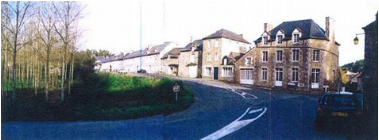
DIGUE DE L'ANCIEN ETANG, front de bâti très homogène, barrière visuelle, très visible depuis l'arrière du bâti, à partir de «îlot de la poste»
