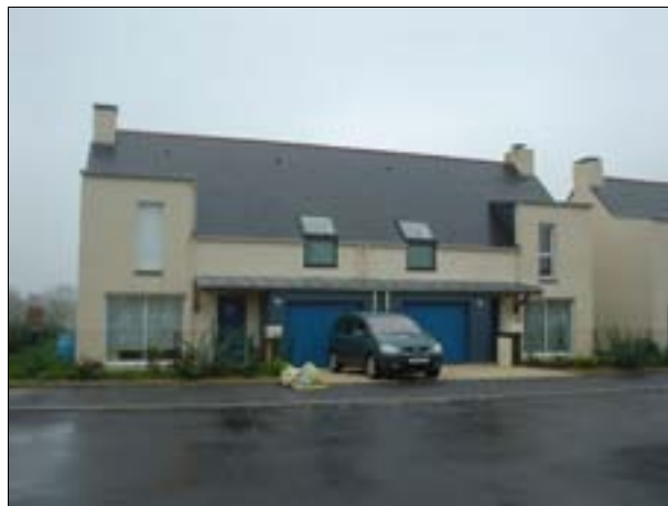
Exemple de logement indiv. groupé
