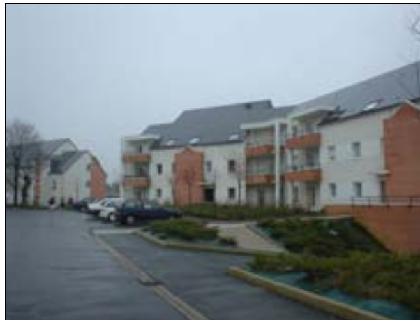
Exemple d'opération collective
