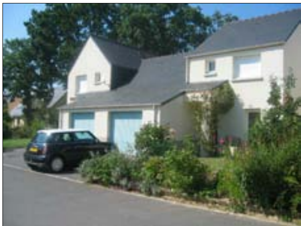
Exemple de logement indiv. groupé
