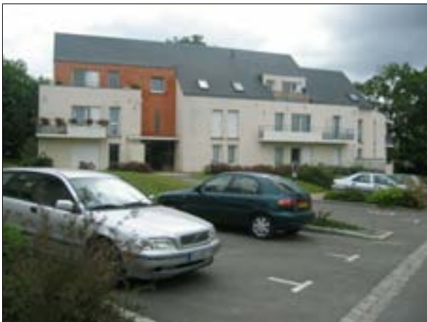
Exemple d'opération collective
