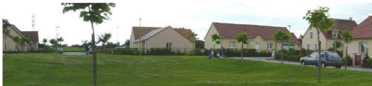
Bassin de rétention faible profondeur
