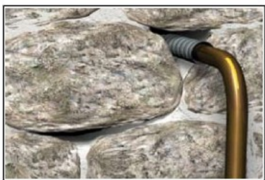
Situation initiale avant colmatage
