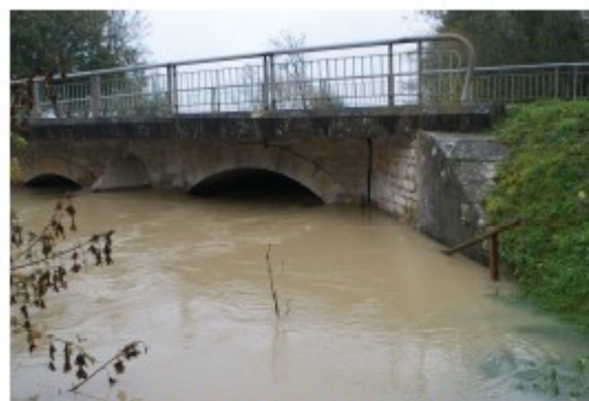
Station limni DREAL : pont sur la Vouge
