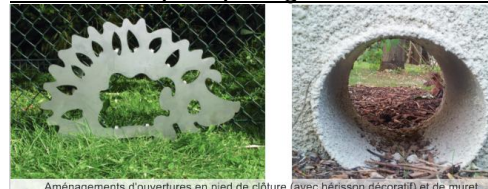
Aménagements d'ouvertures en pied de clôture (avec hérisson décoratif) et de muret. Source : « Les Fiches techniques - Limiter l'impact des clôtures sur la biodiversité » de U2B (Urbanisme bâti et Biodiversité)
