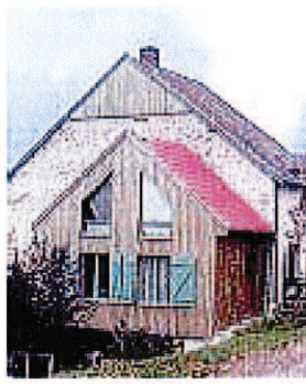
Percements en pignon
