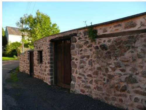
Muret d'une habitation, RD 177c
