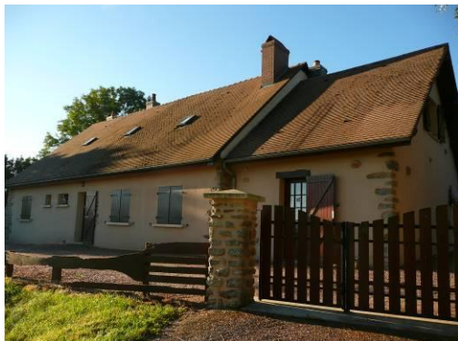
Première habitation traditionnelle en provenance de Saulieu, RD 117c
