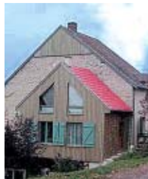
Percements en pignon
