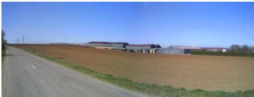
La scierie vue depuis la RD 101
