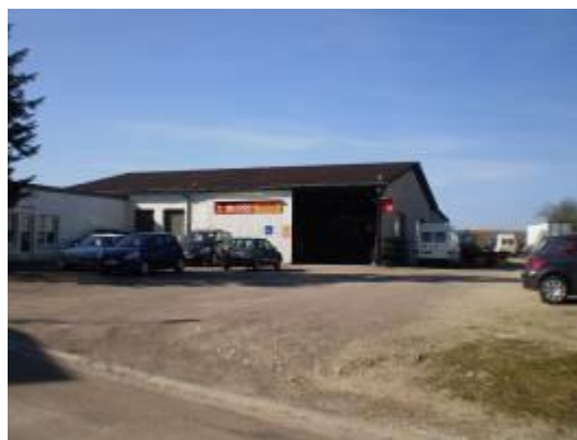
Le garage automobile, entrée nord du village
