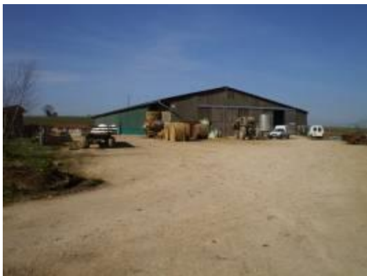
Ferme rue de Grignon
