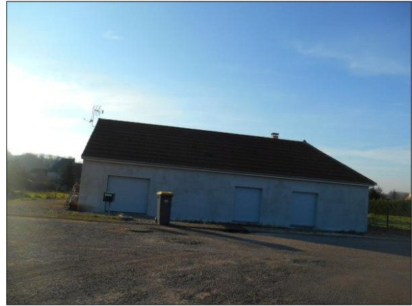
Maison en construction
