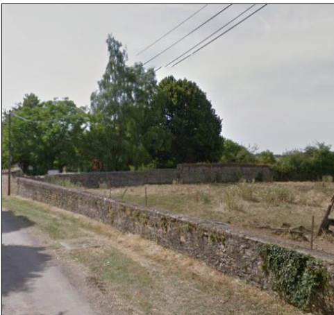
Entrée Nord-est de TOUTRY
