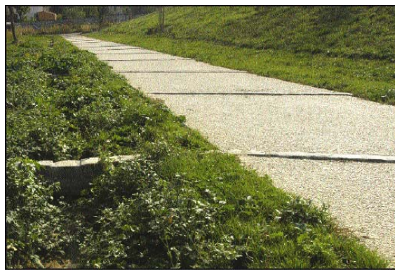
Allée piétonne et sa noue latérale
