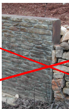
Béton à empreinte et imitation de matériaux
