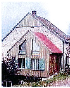
Percements en pignon
