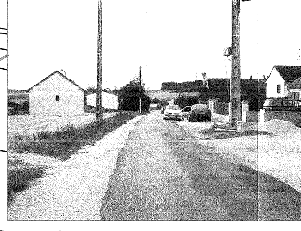
Chemin de Touillon à restructurer
