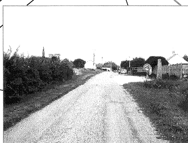
Entrée Est : lotissement en cours de réalisation
