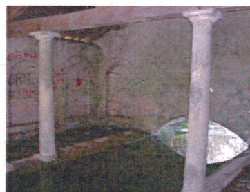
Intérieur du lavoir
