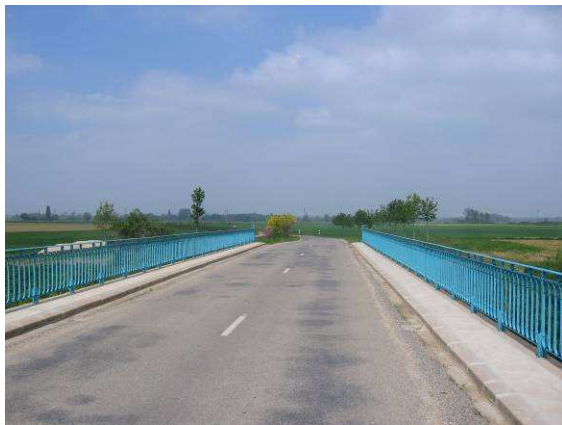
Le pont de la Grande Ouche
