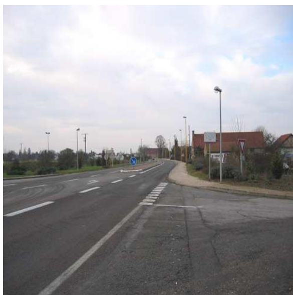
Vue sur le carrefour, intersection avec la voie de service.
