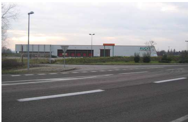
Vue sur l'amorce de voirie coté sud de la RD 905
