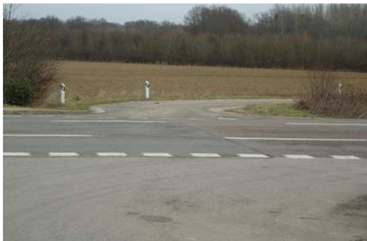
Voie de service depuis l'accès de l'entrepôt.
