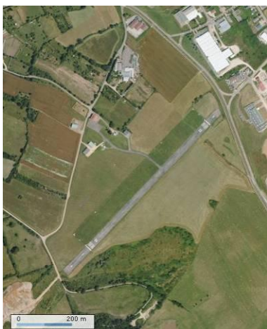
Vue aérienne de la piste de l'aérodrome
