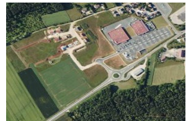
Vue aérienne frange Ouest à traiter
