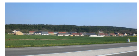
Pavillonnaire récent en entrée de ville
