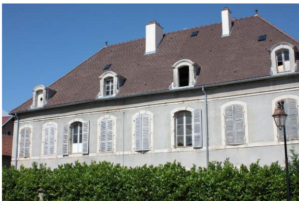
Grande bâtisse dans le centre ancien
