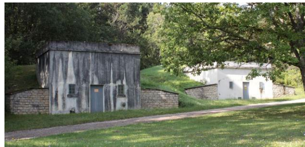
Des réservoirs semi-enterrés
