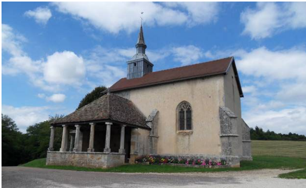
La chapelle vue depuis son accès par le village
