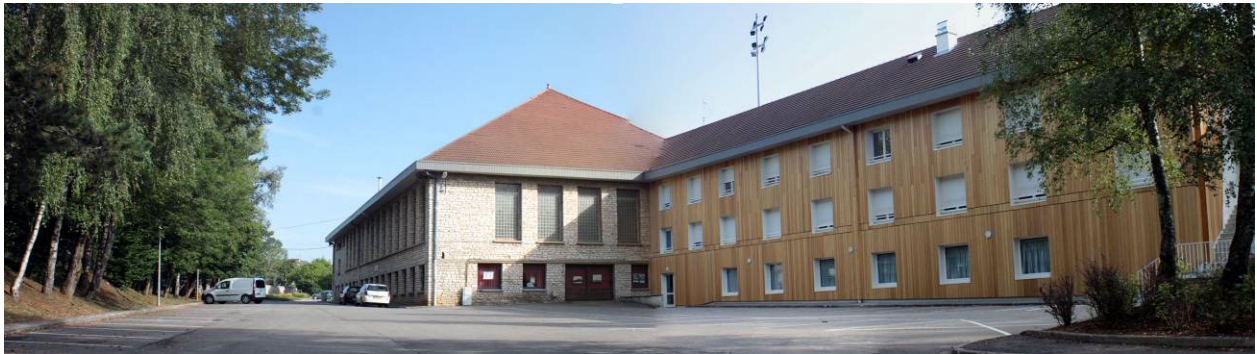
Extension du centre sportif en bois
