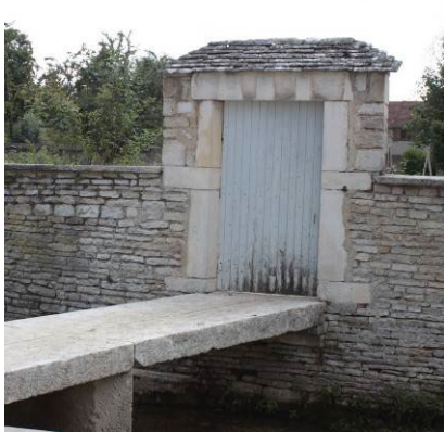
Porte avec passerelle
