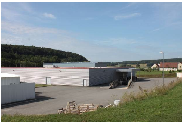
Arrière des bâtiments de la zone commerciale au Sud-Ouest
