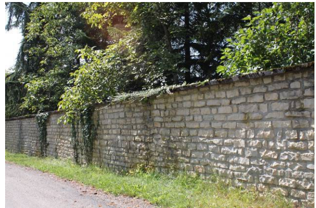
Muret entourant une grande propriété
