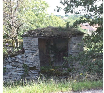
Double porte d'accès aux potagers
