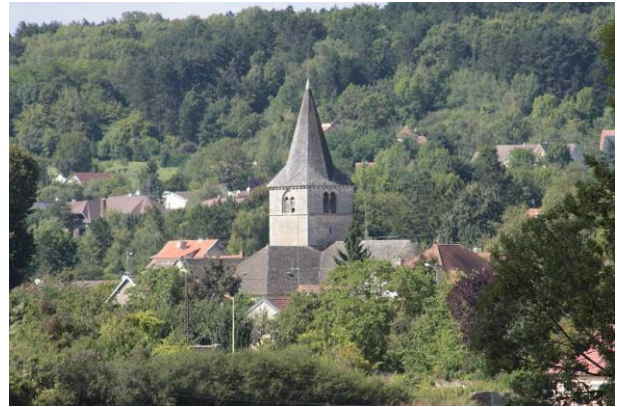
L'émergence du clocher dans la silhouette bâtie
