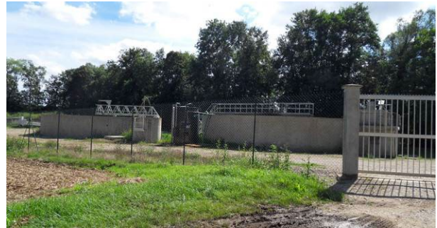
La station d'épuration
