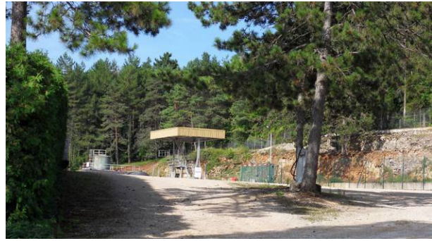
Le dépôt pétrolier
