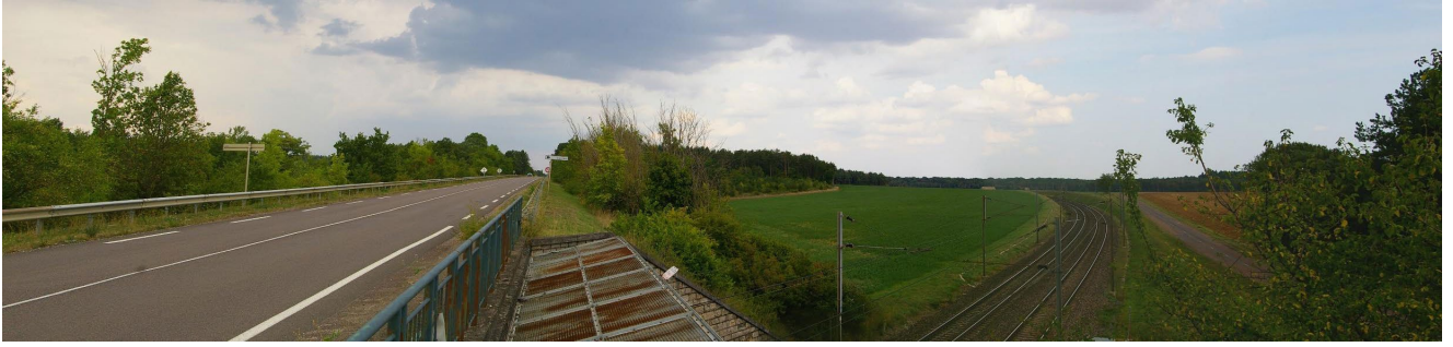
Vue depuis la D974 au-dessus de la ligne TGV
