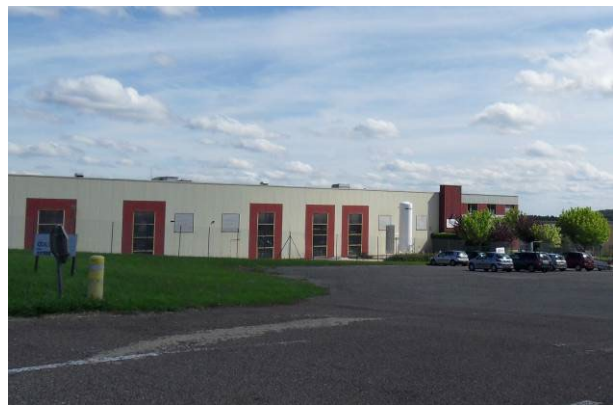
Bâtiment de la zone industrielle au Sud-Est
