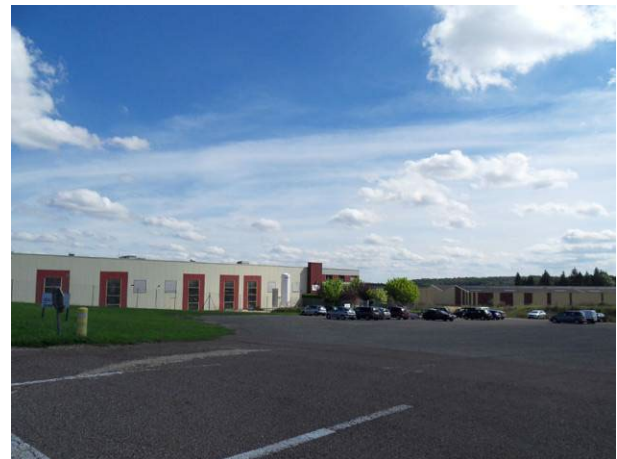
Nouveau bâtiment dans la ZI
