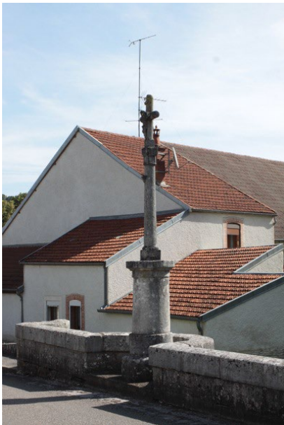
Exemple d'un calvaire sur un pont
