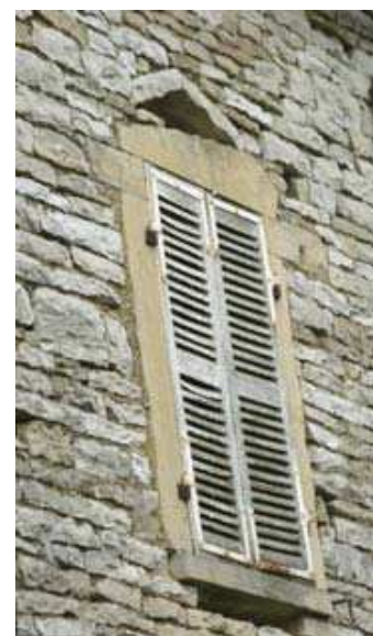
Des fenêtres traditionnelles avec arc de décharge en pierre
