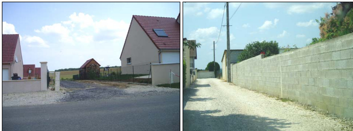
Constructions récentes et clôtures non enduites en limites de parcelles
