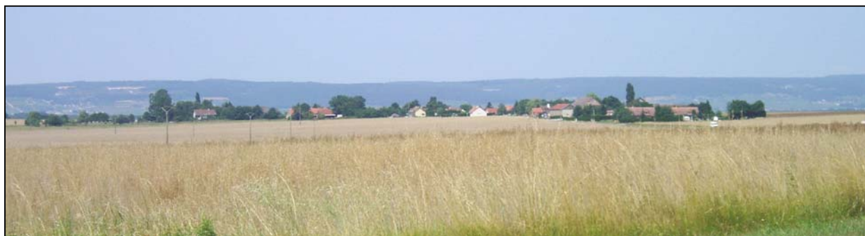
Vue du village depuis la RD 966, le végétal accompagne le bâti. Le village groupé se détache sur la Côte.
