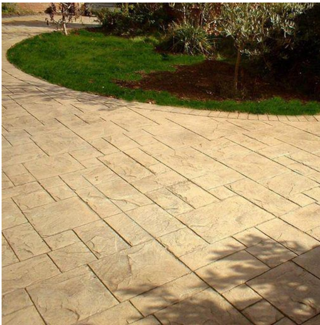
Exemple de dallage non jointif adapté au contexte local (source : creation-sud.fr)
