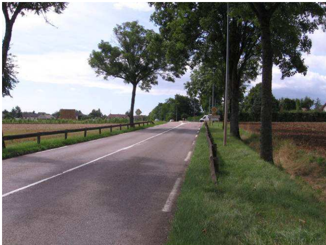
Entrée Nord en provenance d'Epagny
