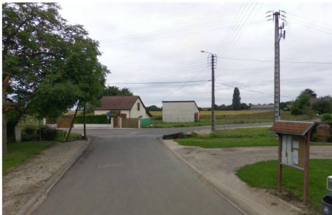
Illustration 17: Fiche de plus hautes eaux au croisement de la rue de la Fontaine et de la Grande Rue
