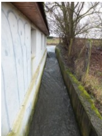
Illustration 9: Seuil de décharge de la Cent-Fonts vers le Milleraie
