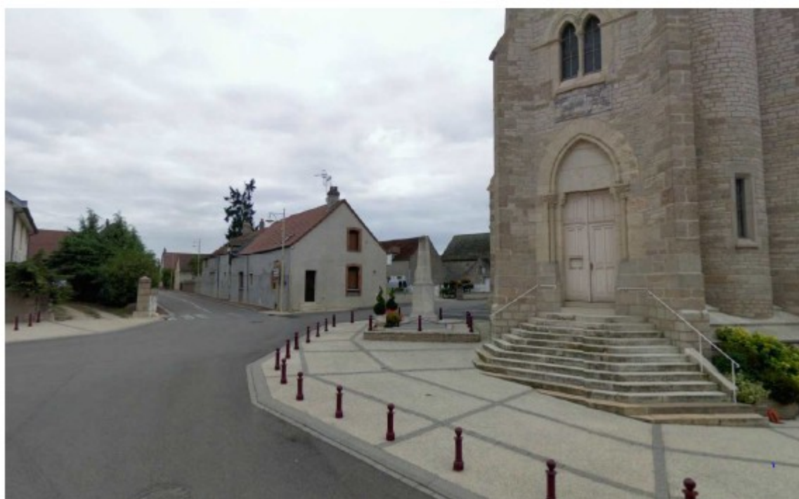
Illustration 15: Fiche des plus hautes eaux au croisement de la rue du Moulin et de l'avenue de la gare
