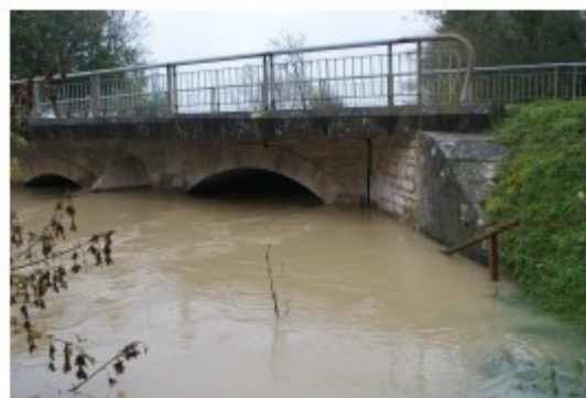
Station limni DREAL : pont sur la Vouge
