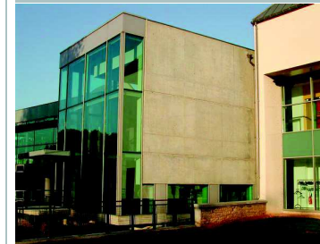
L'architecture contemporaine utilise les propriétés esthétiques du béton et de ses différentes finitions.
