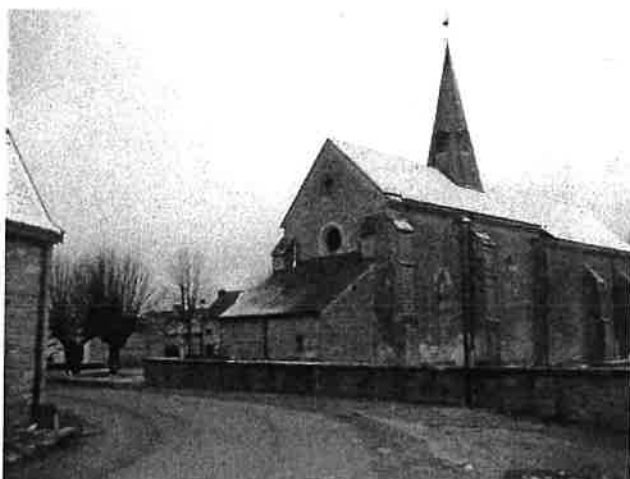
Vue sud-ouest depuis le site vers le bourg et l'église.
