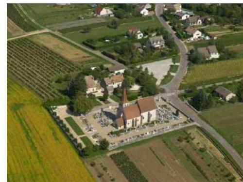
L'église, vue aérienne
