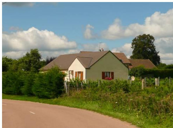
Maison récente à l'entrée Est du hameau
