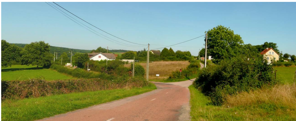
Entrée Sud-Est de Joux depuis la RD4b
