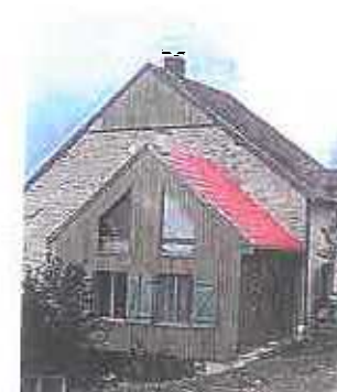
Percements en pignon
