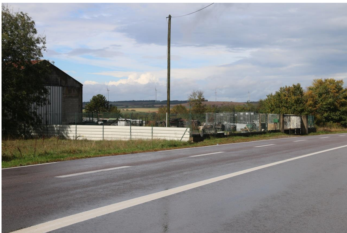
Le Plateau de Bel Air : aucune structuration dans l'entrée.
