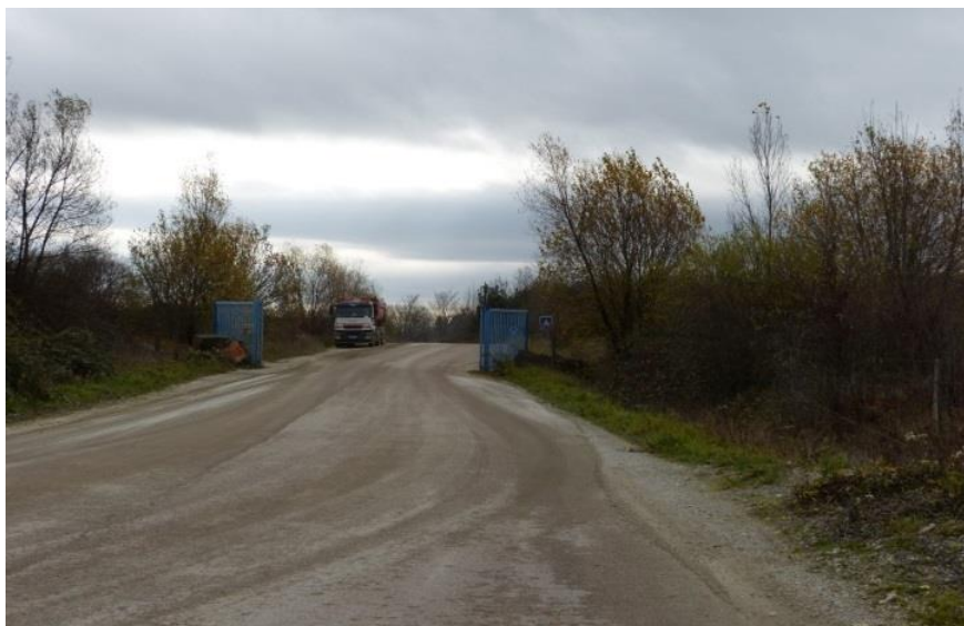
Accès à la carrière, le front de taille n'est pas visible
