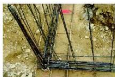
Nœud de chaînage - Continuité mécanique
