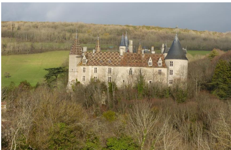
Vue progressive depuis la RD 33
