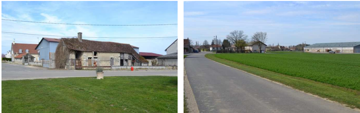
Une ferme délabrée dans le tissu bâti (à gauche) et un hangar agricole à proximité de la zone urbaine (à droite) – Source DORGAT
