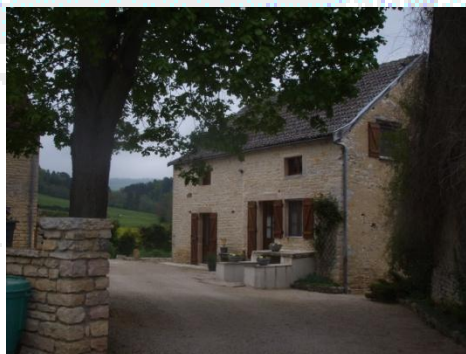
Construction traditionnelle rénovée Source Topos
