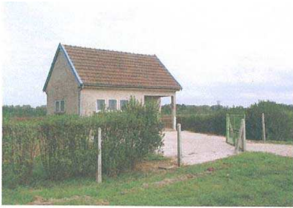
Station de pompage et de traitement à Champdôtre
