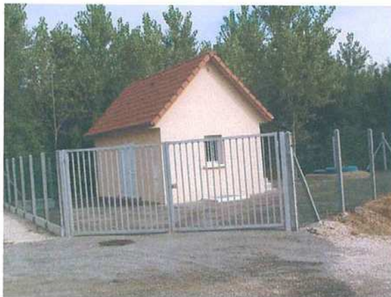
Station de relevage et de traitement du H2S aux Maillys
