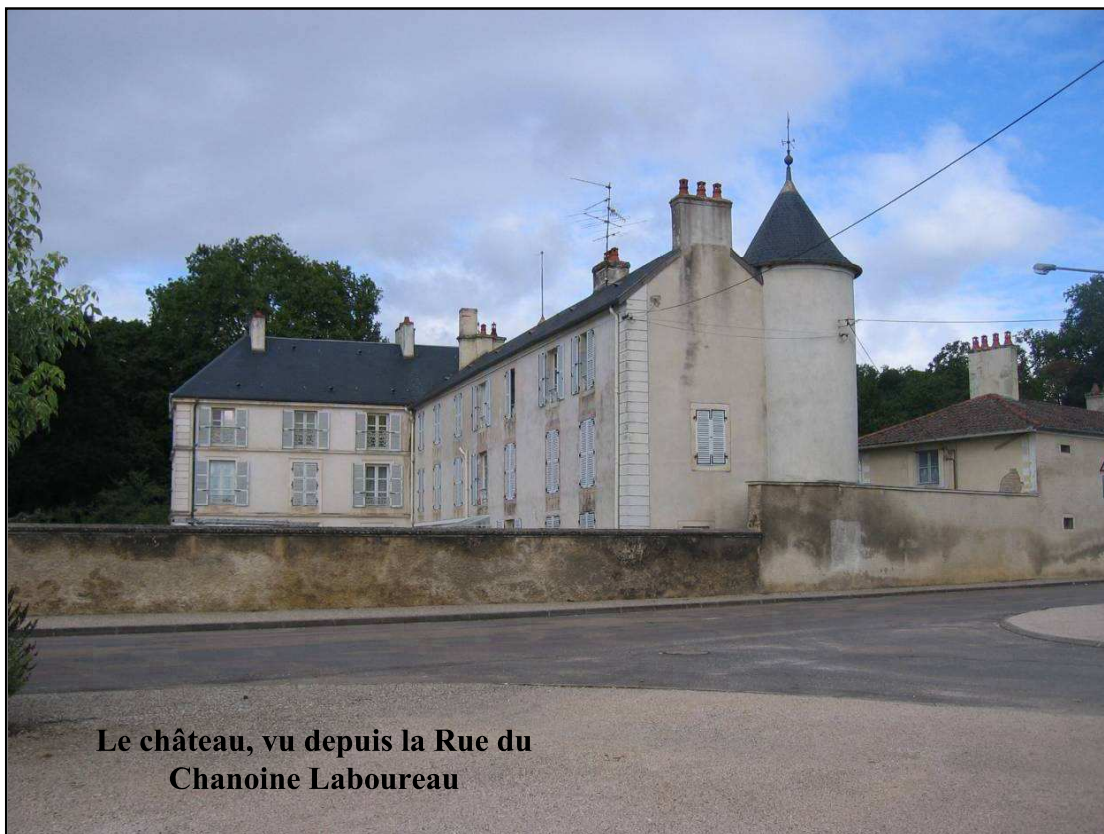
Entrée du Parc du Château, Rue Amiral Violette
