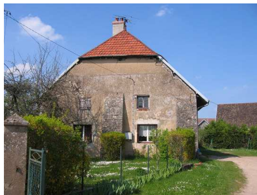
(Vue sur les contreforts du côté sud)
