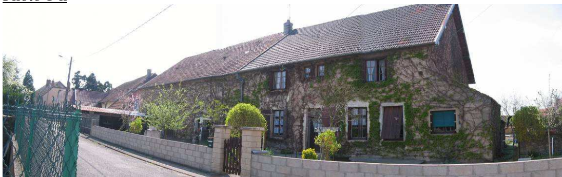
Grange transformée, n° 9 Rue du Berger
