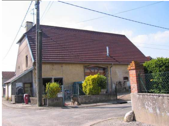
Grange transformée, impasse Fontenis parcelle cadastrée n° 287
