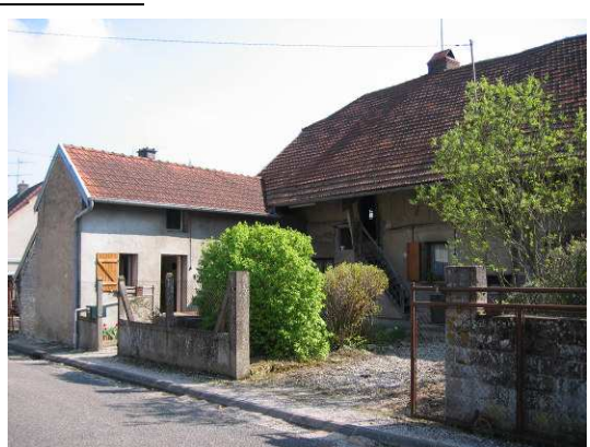
Maison de plaine, rue de la Rente parcelle cadastrée n° 104
