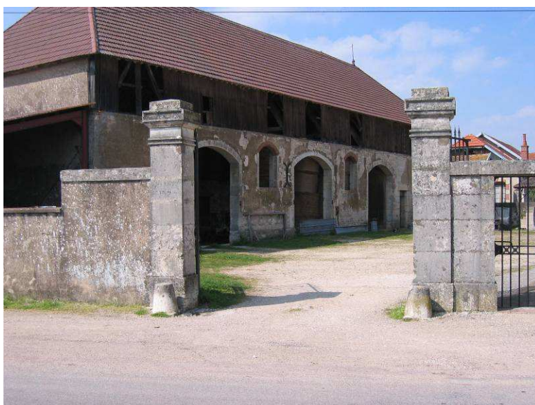
Vue de face de la grange
