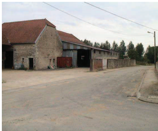
Bâtiments agricoles – rue du Balay
