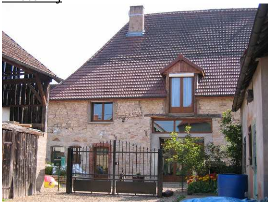
Grange transformée, Rue Notre Dame parcelle cadastrée n° 319 (Vue d'ensemble)
