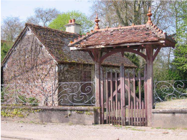
Route de Pontailier parcelle cadastrée n° 188
