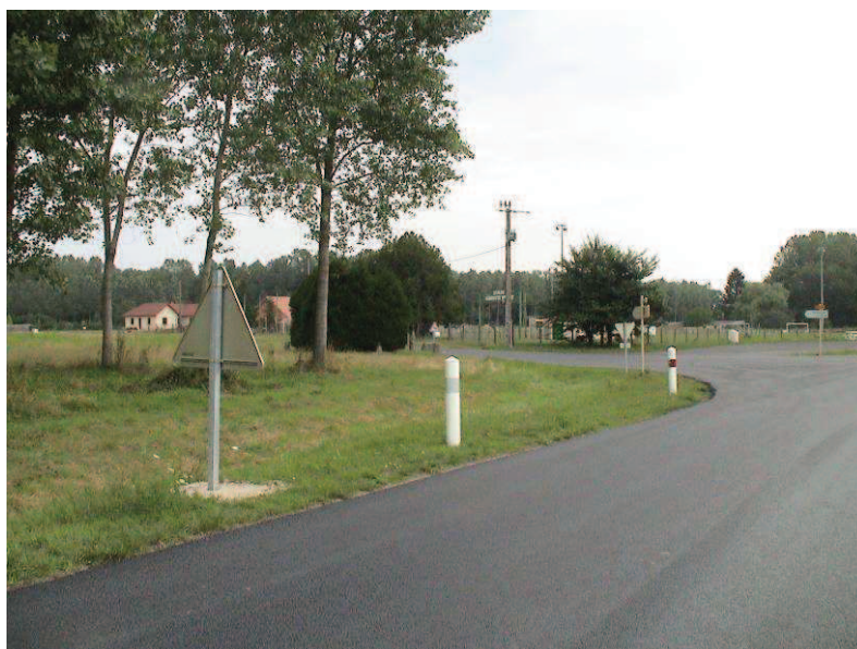
Vue du carrefour entre la D 104 e et la D 959, depuis la D 959 en provenance de Pontailler-sur-Saône
