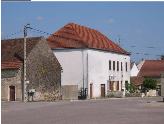
Maison de village, n° 1 Route de Pesmes
