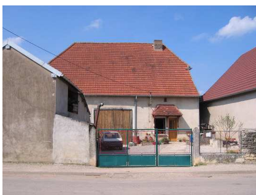
Grange transformée, n° 12 Rue des Leux
