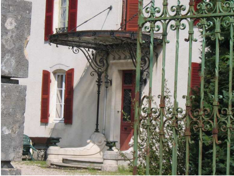
Entrée avec verrière
