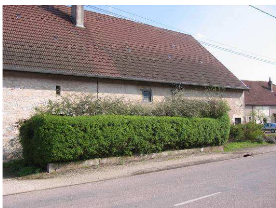
Grange, n° 25 Route Vielverge (vue sur l'ensemble du mur)
