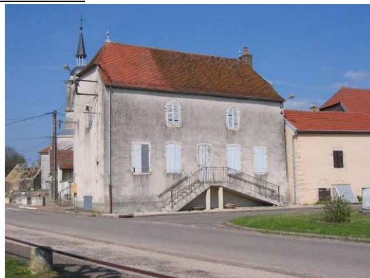
Maison de village, Rue du Souvenir parcelle cadastrée n° 157
