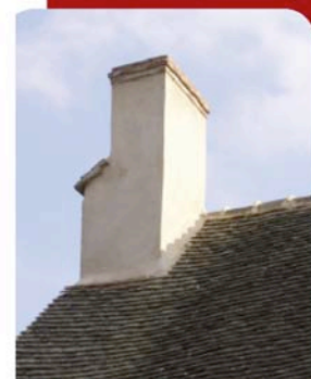
Finition traditionnelles du solin et du faîtage.
