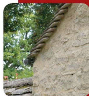
Tuile de rive scellée à l'épaulement. Principe utilisable aussi avec tuile à emboîtement.
