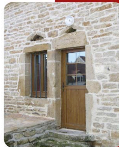
Encadrement avec arcs de décharge
