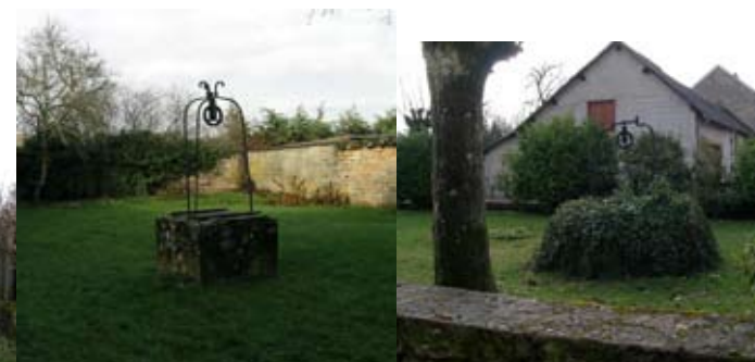
puits implanté dans le jardin de la mairie
