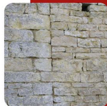
Jonction entre 2 murs avec des pierres de liaison.
